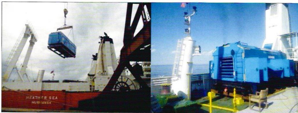
Рисунок 15 – Компрессорная станция ТГА-10/220
